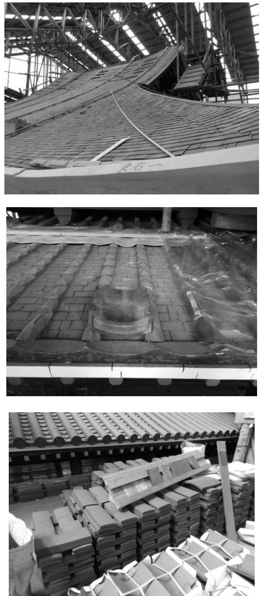
図8 鳳凰堂に対する平成修理現場
